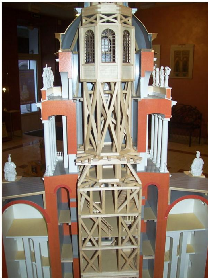
Рис. 8. Разрез Адмиралтейского шпица по модели
